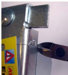
Après la mise sous tension de la ligne de télécommande, couper le fil acier qui entoure le module.
